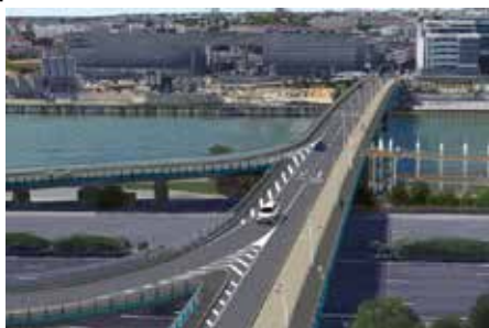
Vue du pont en amont
