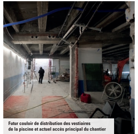
Le défilage de la quasi-totalité des plafonds de l'ouvrage a été fait
