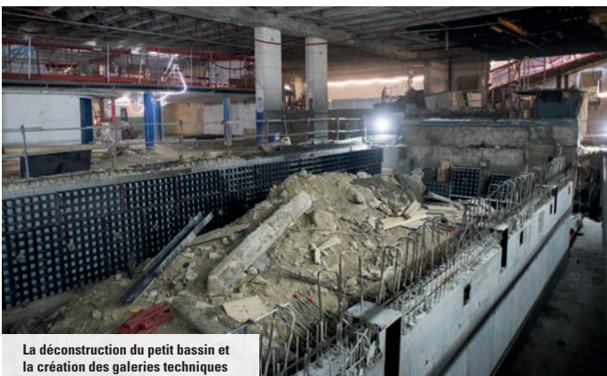
La démolition des bancs en serpentins est achevée
