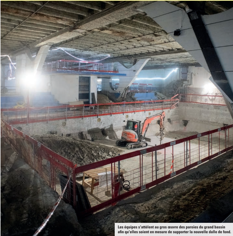
Le défilage de la quasi-totalité des plafonds de l'ouvrage a été fait
