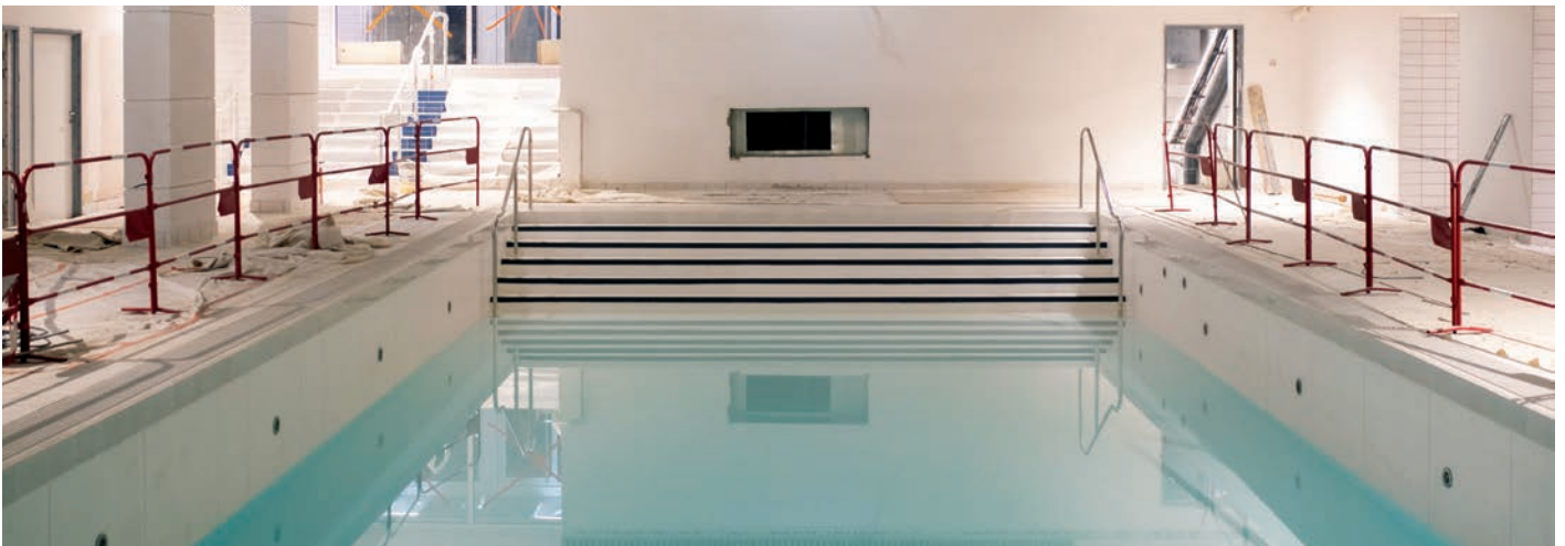
15 mars 2022 La mise en eau des 2 bassins (ici le petit) marque une étape emblématique du chantier. Prochaine étape importante : la pose de l'ascenseur et des portillons d'accès.
