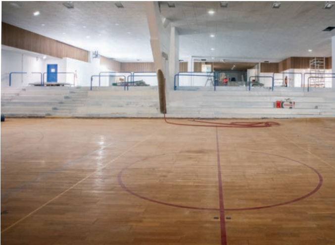
Le terrain de basket sera prochainement doté de nouveaux paniers. Un nouvel éclairage led répondant aux exigences de la Fédération a été posé. Peintures et faux-plafonds ont également été rénovés.
