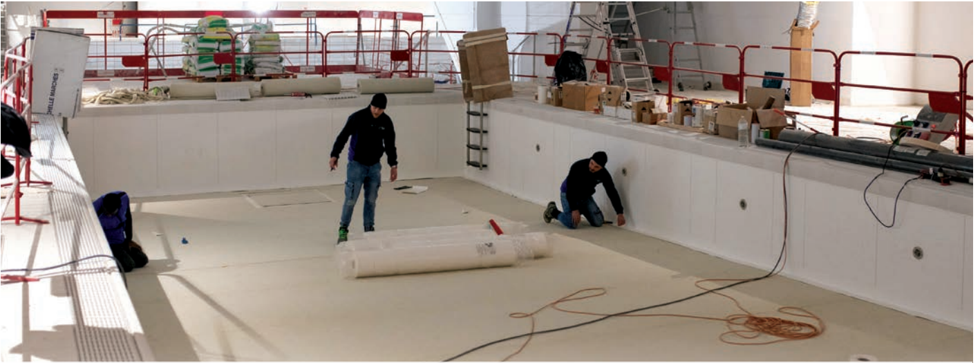
Pose d'un revêtement innovant (membrane en lès soudés) garantissant l'étanchéité du fond du petit bassin. Le tour est recouvert de panneaux en acier inox.
